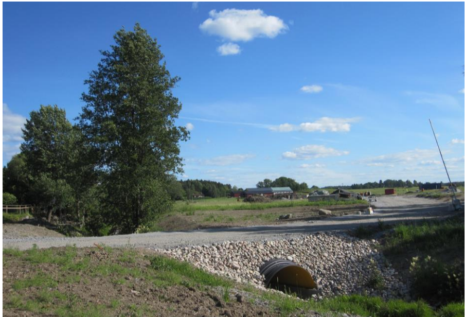
Ny vägbro för in- och utfart till det nya bostadsområdet. Foto: 2016-06-28
